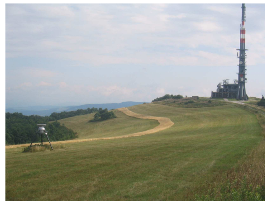
meteorologická stanice na Javořině
